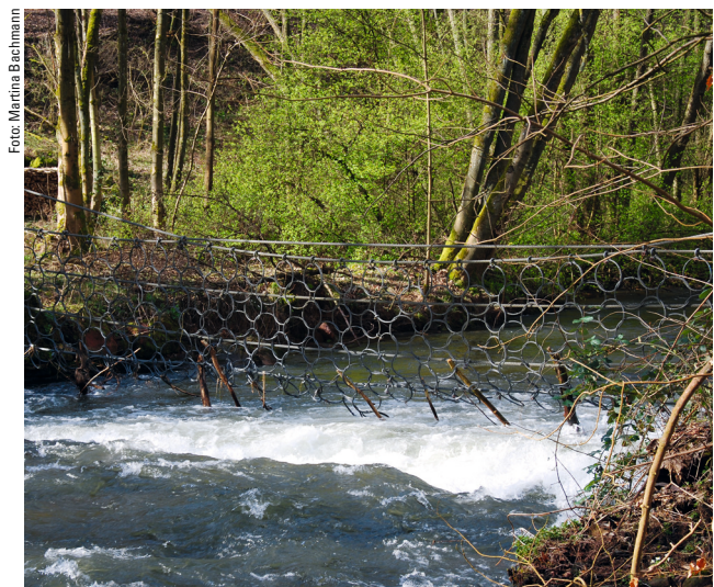
Netz als Schutzeinrichtung zum Abfangen von Totholz vor gefährdeten Bereichen
