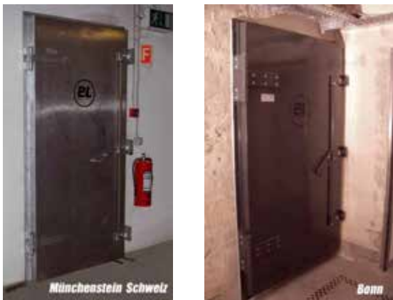
Abb. 7-7 Hubschwenktor (Fotos: Blobel Umwelttechnik GmbH)
