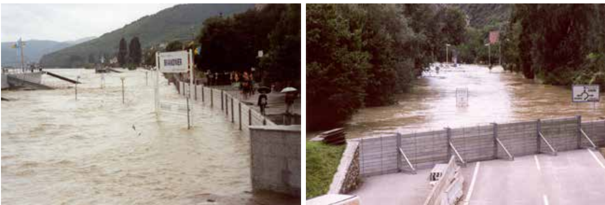
Abb. 7-3 Dammbalkensystem im Hochwasserfall (Fotos: Amt der NÖ Landesregierung)
