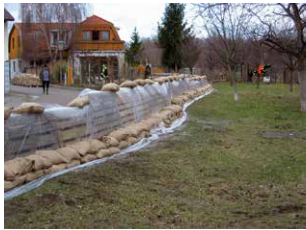
Abb. 7-22 Stellwandsystem mit Europaletten, Dichtfolie erforderlich (Fotos: BFKDO Gänserndorf)
