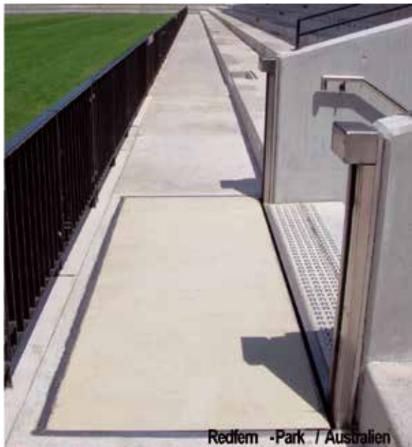
Abb. 7-10 Klappwand im Einsatz und in Normalposition, Oberfläche der Umgebung angepasst (Fotos: Blobel Umwelttechnik GmbH)
