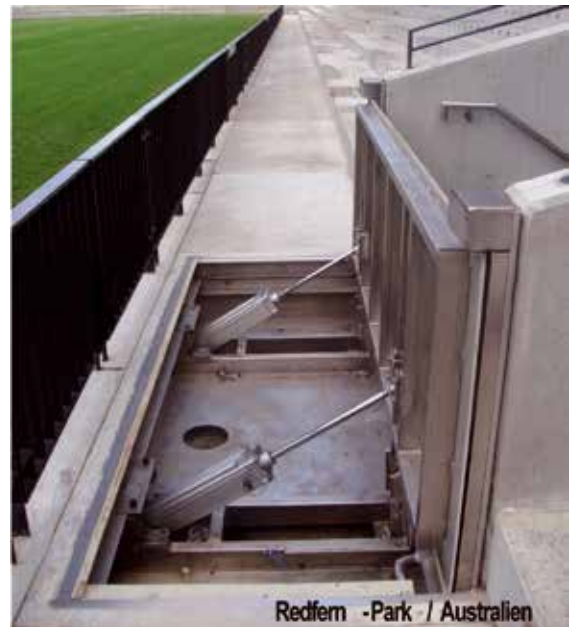
Abb. 7-10 Klappwand im Einsatz und in Normalposition, Oberfläche der Umgebung angepasst (Fotos: Blobel Umwelttechnik GmbH)
