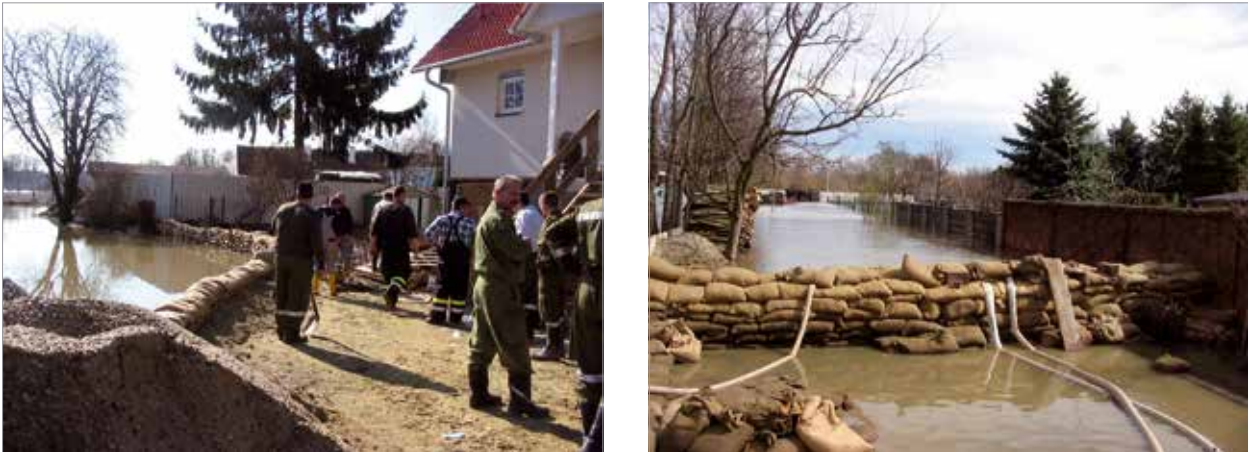
Abb. 7-17 Aufbau eines Sandsackwalls (Fotos: BFKDO Gänserndorf)
