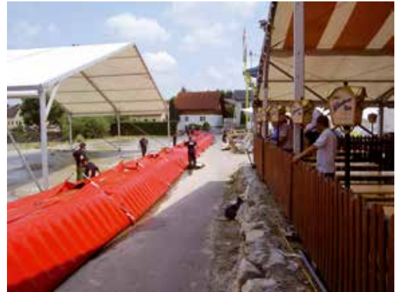
Abb. 7-27 Trapezförmig geschlossenes Behältersystem, System im Einsatz (Fotos: BFKDO Gänserndorf)
