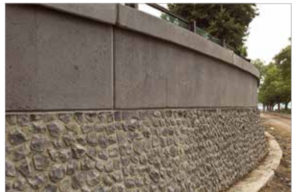
Abb. 7-15 Aufstockung einer Schwergewichtsmauer mit einem 40-cm-Glaswandsystem in Köln-Westhoven am Rhein, um den geforderten Schutzgrad zu erreichen (Fotos: Stadtentwässerungsbetriebe Köln/Peter Jost)
