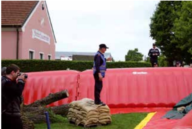
Abb. 7-27 Trapezförmig geschlossenes Behältersystem, System im Einsatz (Fotos: BFKDO Gänserndorf)
