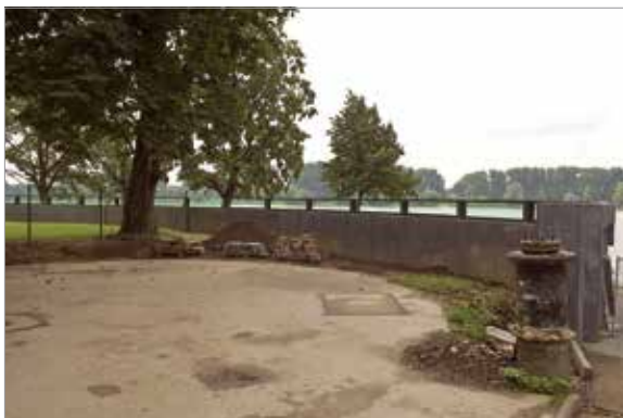
Abb. 7-15 Aufstockung einer Schwergewichtsmauer mit einem 40-cm-Glaswandsystem in Köln-Westhoven am Rhein, um den geforderten Schutzgrad zu erreichen (Fotos: Stadtentwässerungsbetriebe Köln/Peter Jost)
