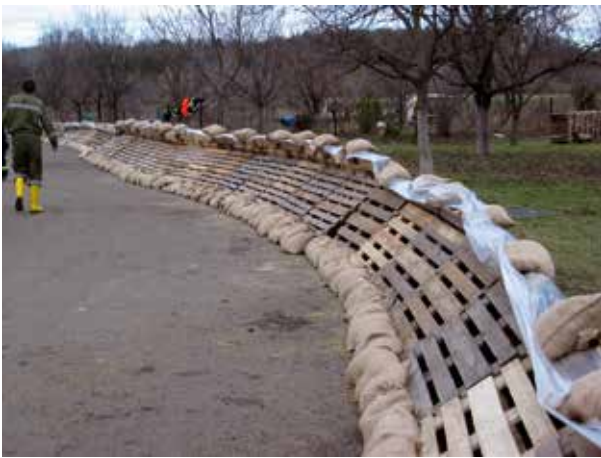
Abb. 7-22 Stellwandsystem mit Europaletten, Dichtfolie erforderlich (Fotos: BFKDO Gänserndorf)
