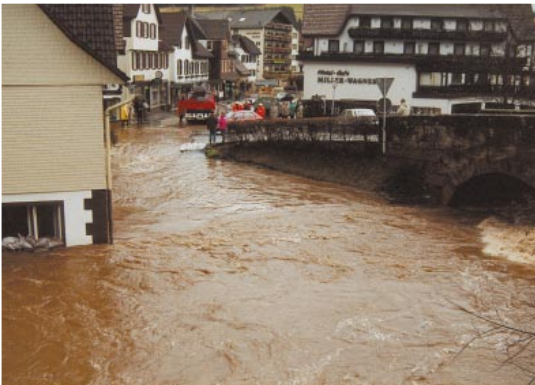
Bild 9: Hochwasser in Baiersbronn 1990
