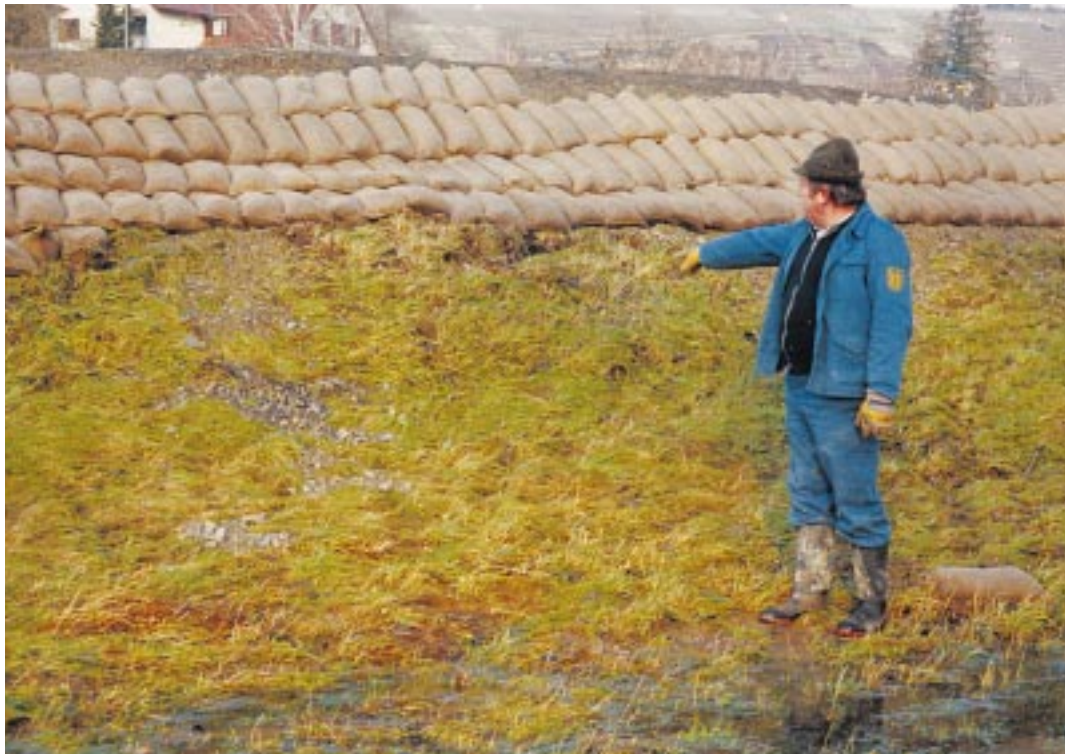
Bild 8: Sandsacksicherung beim Hochwasser 1993 in Vaihingen/Enz – Rosswag
