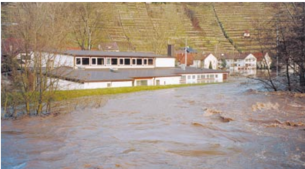
Bild 3: Dammüberströmung in Vaihingen/Enz – Rosswag 1993
