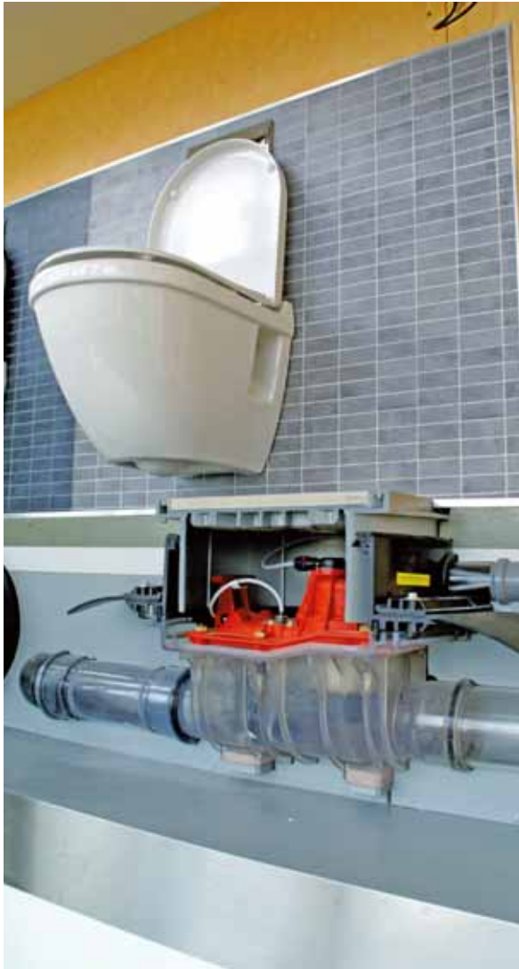
Abb. 7: Beispiel für eine Rückstauumpenanlage unterflur eingebaut (Ausstellungsdarstellung) (Quelle: Modell Pumpfix F, KESSEL AG, www.kessel.de )
