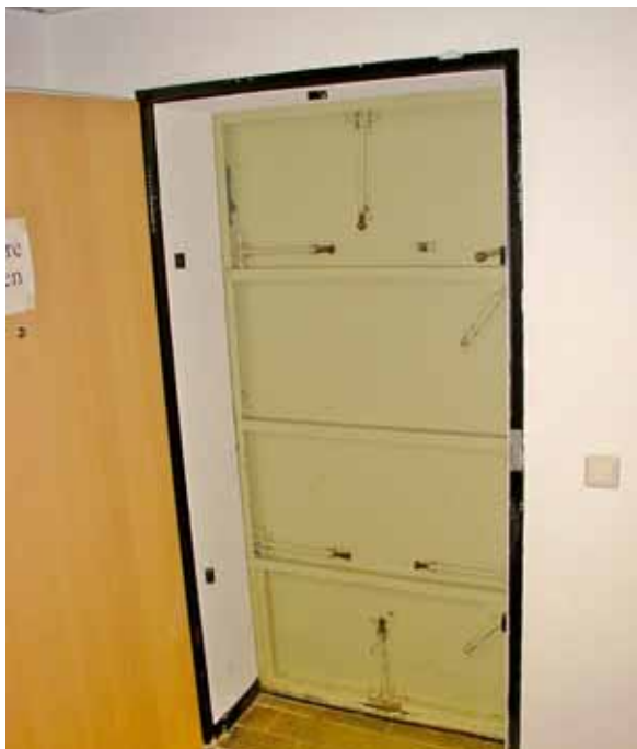
Abb. 11: Beispiel für eine wasserdichte Schiffstür (Quelle: R+V Allgemeine Versicherung AG)
