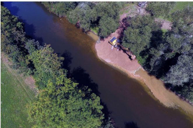
Herstellung eines Kiesdepots am Neckar (links und rechts) [RP Tübingen]
