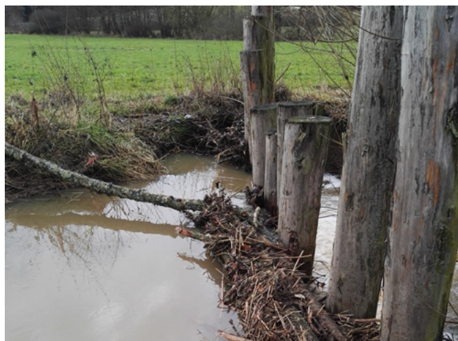
technische Grobrechen im Krebsbach und im Reichenbach [Büro Heberle]
