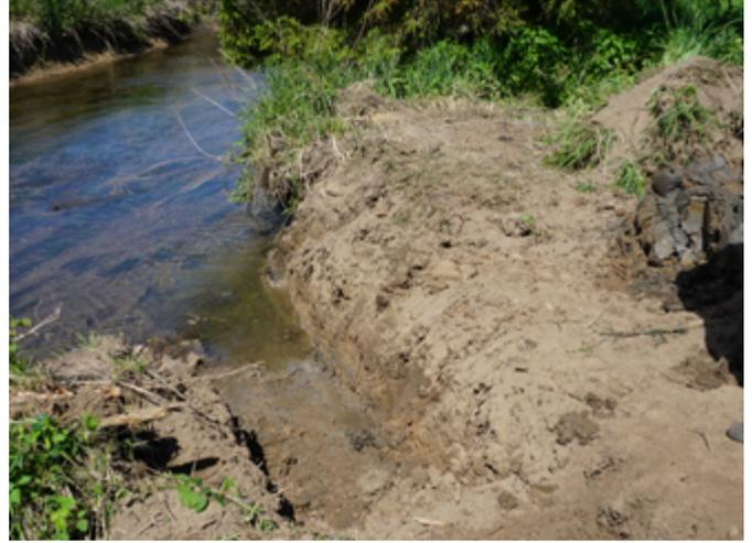
Vor dem Einsetzen des Fangbunkers wird gebrochenes Steinmaterial (Forstmischung 0/16 mm) als Unterbau in der Grube verfüllt und mit dem Baggerlöffel verdichtet. Danach wird der Bisambau eingesetzt und ausgerichtet, sodass der Eingang in Richtung des Gewässers zeigt. Im Bisambau selbst wird der Boden leicht mit Flusssand (0/2 mm) abgedeckt.
