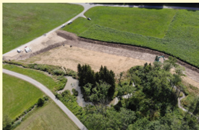
Baustelle am Unterlauf des Tobelbachs [Landratsamt Biberach, Flurneuordnungsamt]
